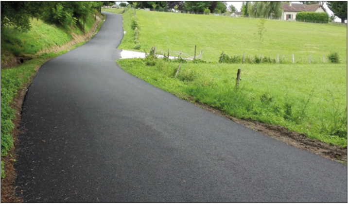
» Travaux route de Puybier et de Bourrèges
