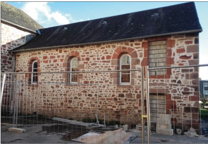
» Travaux de la chapelle
