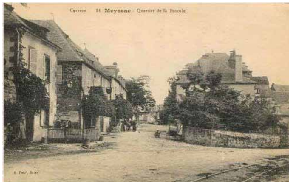
Rue de la Gare, vue depuis l'Ouest, entrée du centre-bourg depuis Brive
