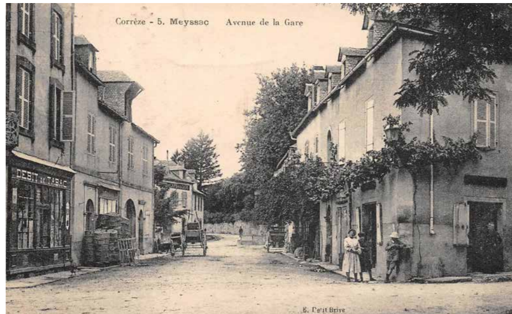
Rue de la Gare, vue depuis l'Est, depuis la place du Jet d'eau
